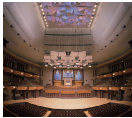
「美しい響き」を追求める工夫がホールの随所に。客席天井には鳥をモチーフにした反響板を採用。舞台上の音響反射板、天井の凸面もその一例。
