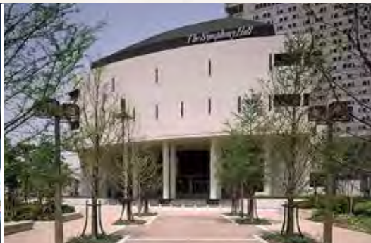
ザ・シンフォニーホール建設当時の姿。30年前は並木道の木々も若々しく、ホール全体が見渡せていた
