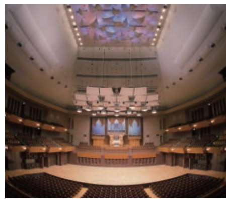
「美しい響き」を追求する工夫がホールの随所に。客席天井には鳥をモチーフにした反響板を採用。舞台上の音響反射板、天井の凸面もその一例。
